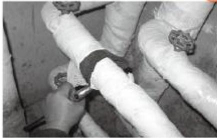
图5 拆除管井过滤器
