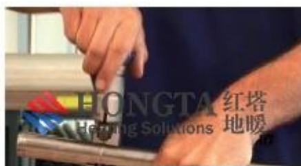
图3 金属管用割刀下料。小口径钢金属管的每次进刀量不宜过大。
