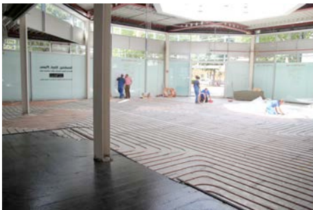
Im Altbau kam ein Gussasphaltestrich zum Einsatz (li.) – in Kombination mit blanken cuprotherm-Kupferrohren (re.)
