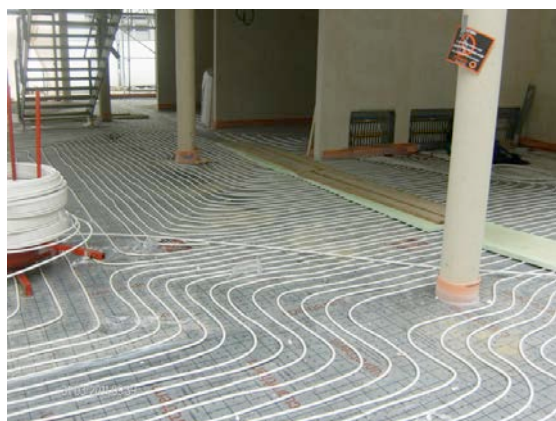
Das flexible Kupferrohr cuprotherm CTX ist besonders leicht zu verarbeiten
