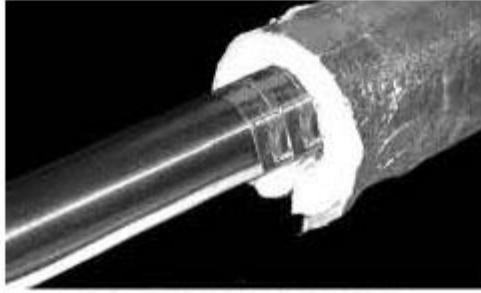
发热电缆管道保温剖面图
