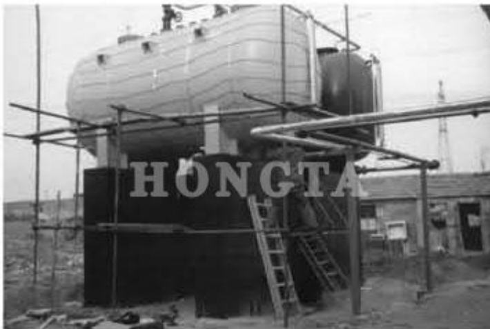
罐体安装发热电缆图
