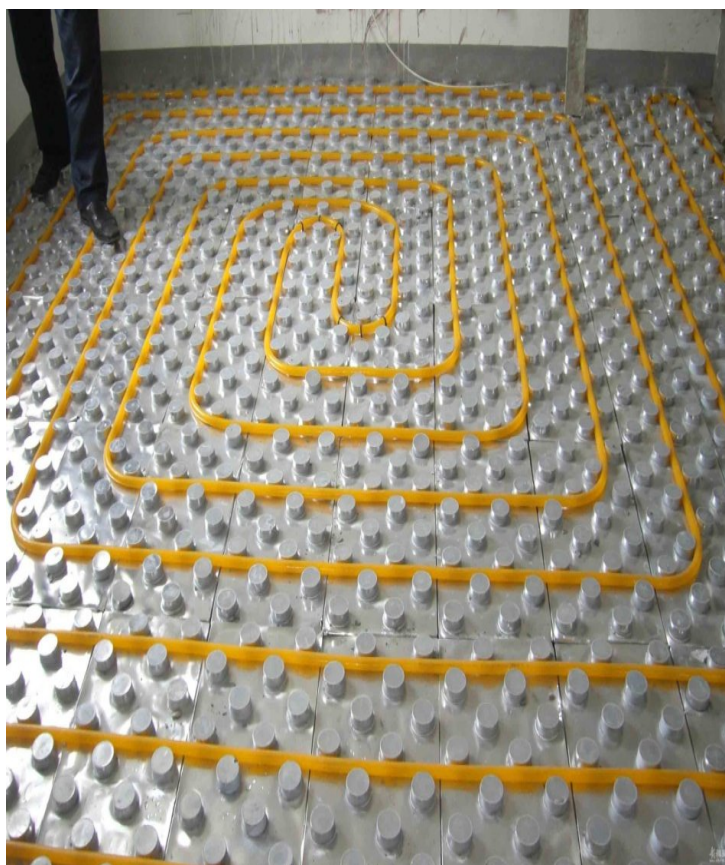
圖 5 水地暖之保溫層施工。 註 5
